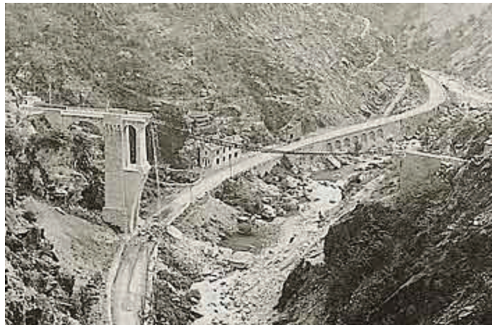
Le viaduc de Scarassouil détruit, 1945
