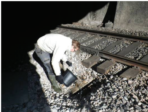
Ouverture sur le canal en sortie de tunnel
