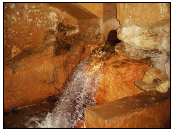
Déversement de la chambre neuve dans la chambre ancienne
