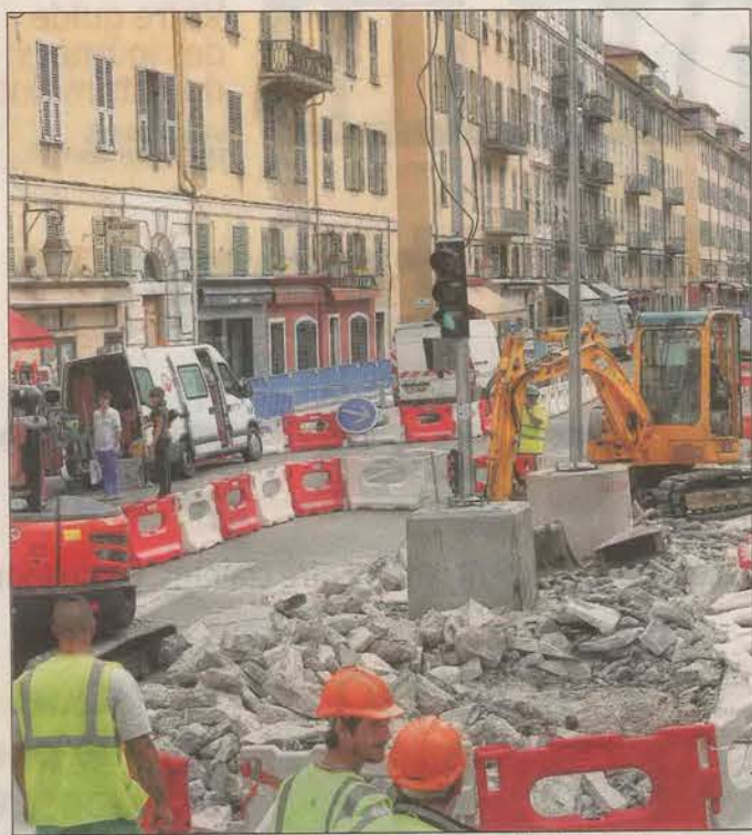
Les grands travaux de la ligne 2 du tram ont commencé près du port.
