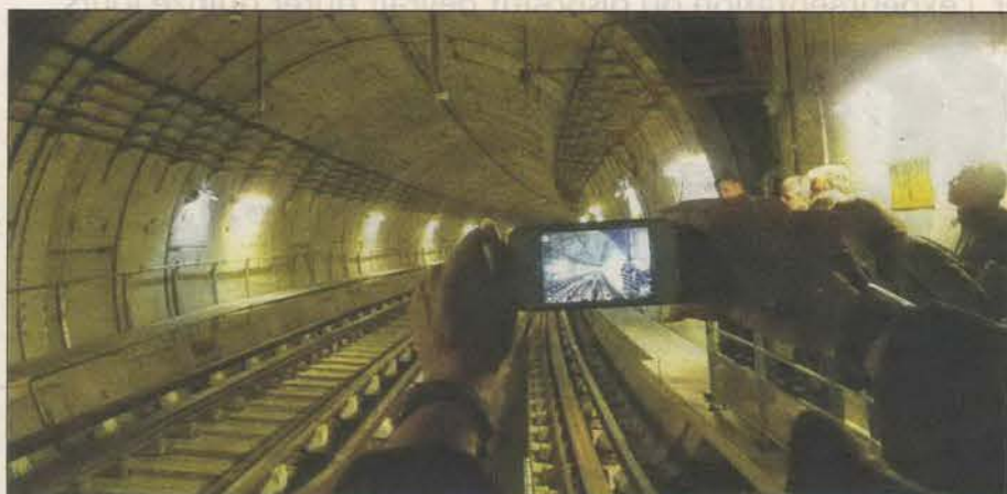
Visite dans le tunnel, creusé à Lyon sous le Rhône et dans une nappe phréatique, à Oullins.
