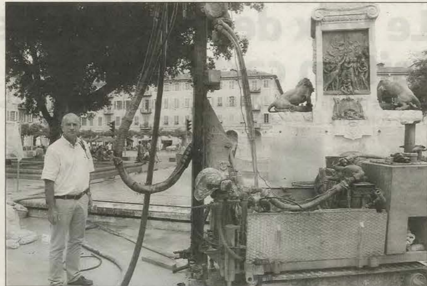
Pour le géologue niçois, ici devant le sondage réalisé place Garibaldi pour le futur tunnel du tramway, les forages doivent descendre jusqu'à une centaine de mètres pour recueillir le maximum d'informations.
