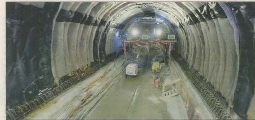
Le chantier du tunnel de Toulon : un long cauchemar pour les Toulonnais.
