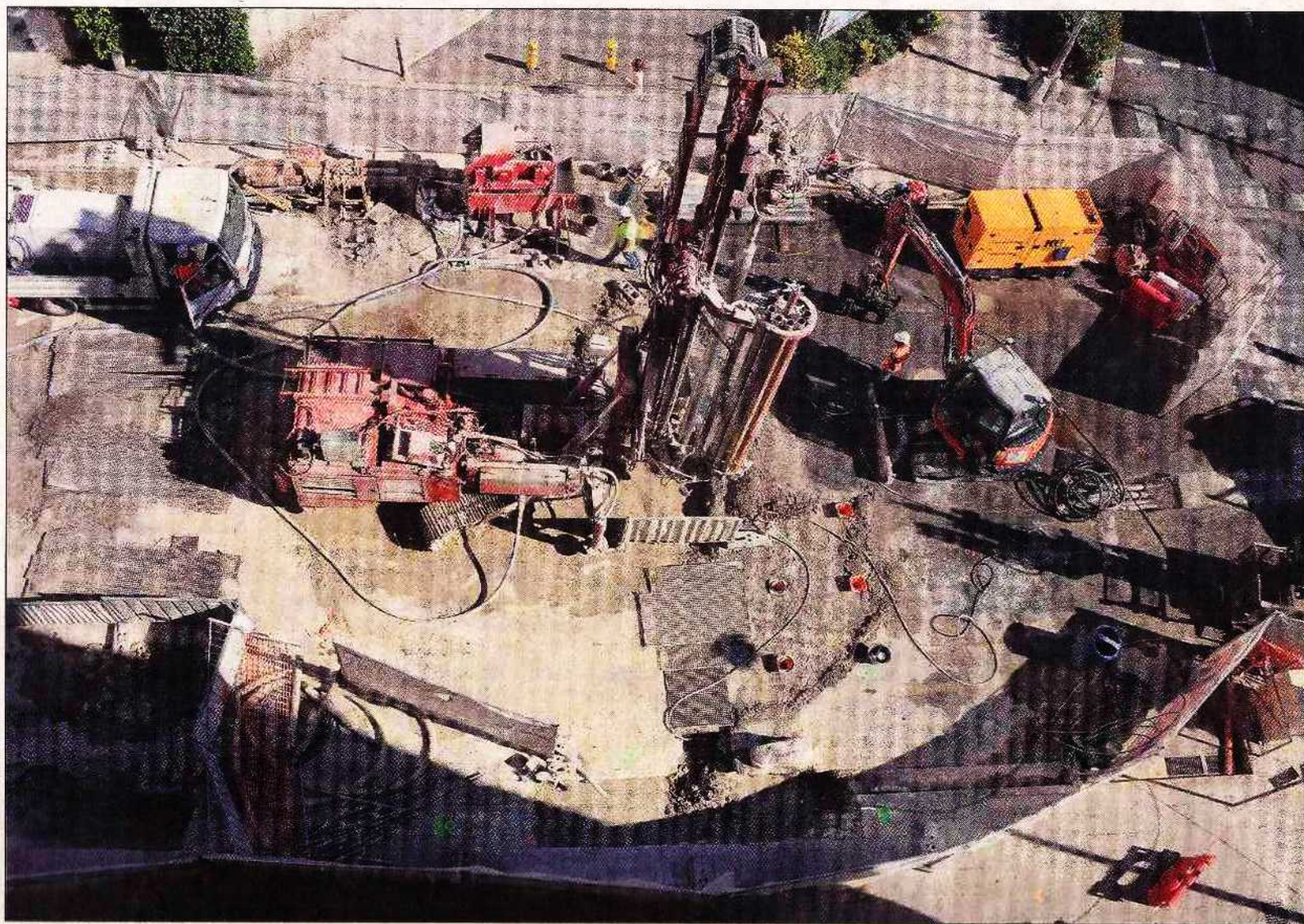
Depuis le 4 juillet, les ouvriers travaillent à consolider le terrain et le tunnelier est à l'arrêt.
