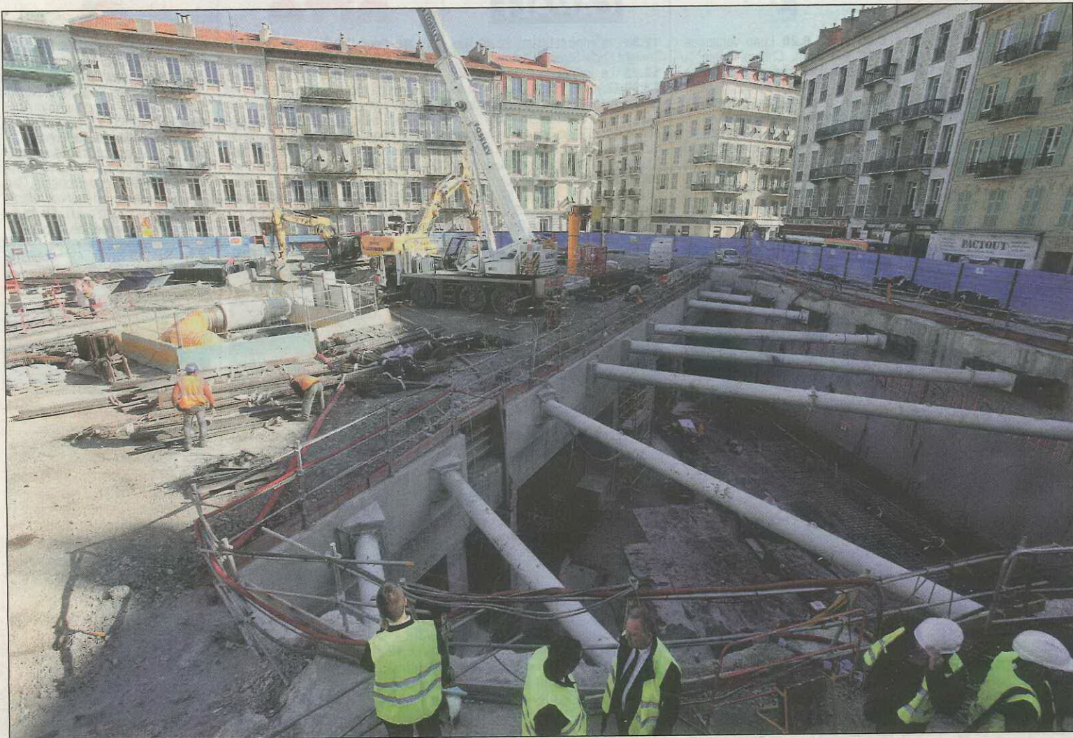
A l'angle des rues Gubernatis et Hôtel-des-Postes, le chantier a démarré à l'été 2014 par la transplantation des arbres remarquables (notamment des palmiers) du jardin Durandy. Les gros travaux ont été lancés en février 2015. La dalle de couverture a été coulée en août dernier et le tunnelier a traversé la station en septembre. (Photos Cyril Doderigny)
