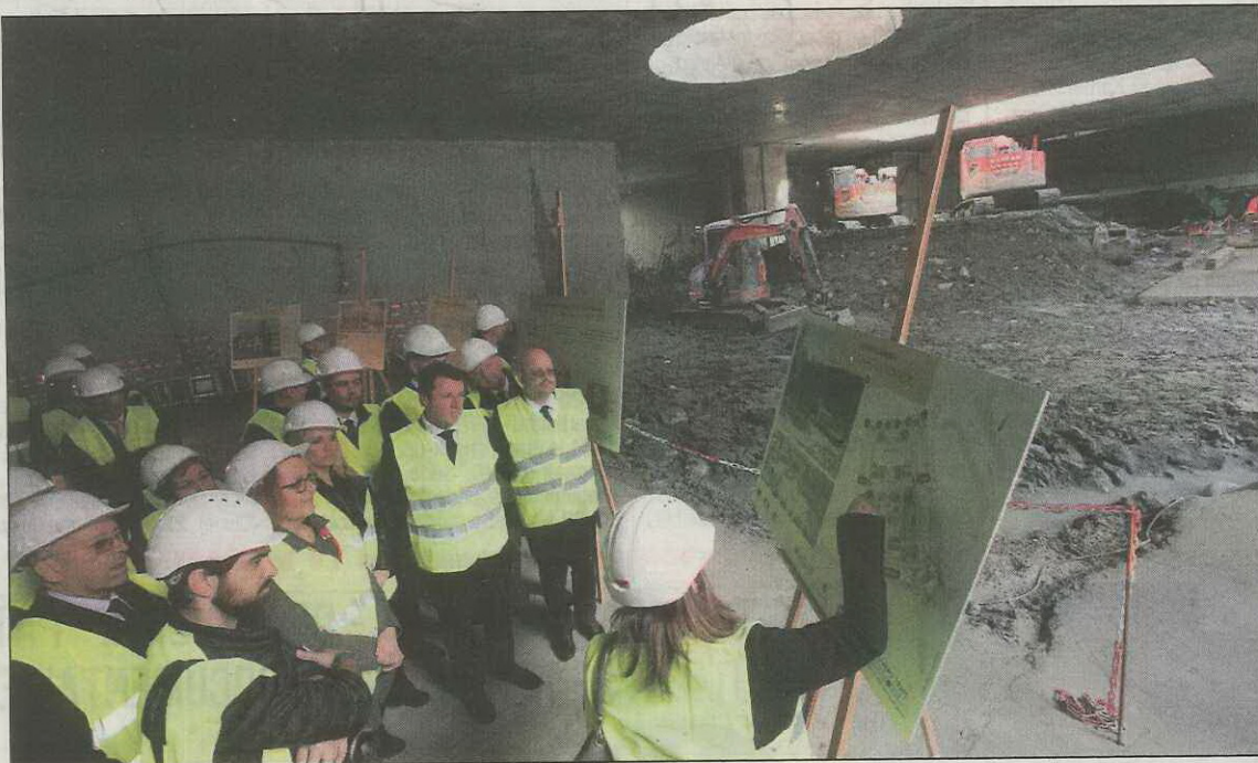
Première visite de chantier ouverte à la presse de la station « Durandy », hier. Des visites pour le grand public sont programmées.
