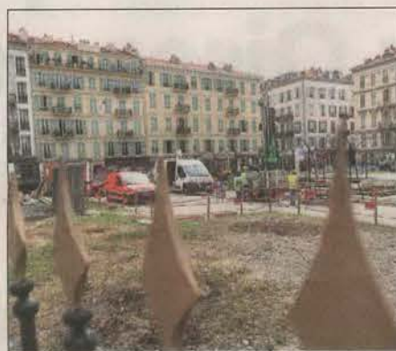
Au square Durandy, proche de l'avenue Jean-Médécine, le chantier est bien visible.
