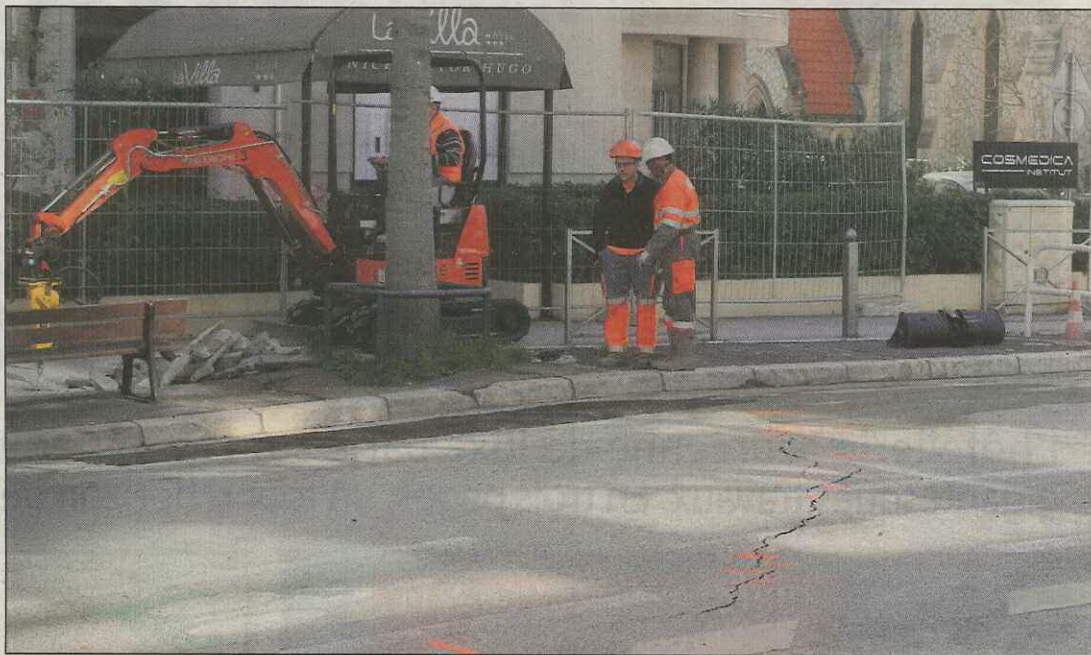
L'asphalte s'est fissuré et une canalisation d'eau s'est rompue. Le gaz a été coupé par précaution. Aucune fuite n'a été détectée mais Grdf mène des investigations sur son réseau qui dureront au moins jusqu'à ce soir.
